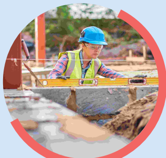
Caroline MATHIEU Chantiers BTP
